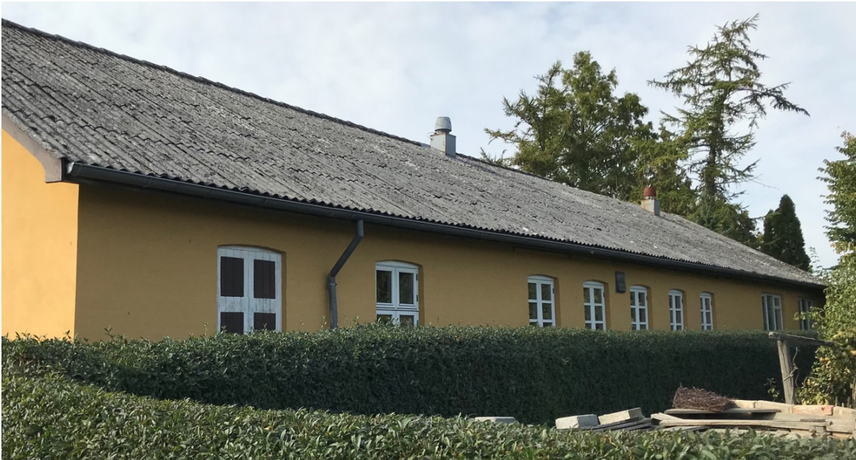
Havrebjerg forsamlingshus set fra sydøst. Man kan se, at taget på østsiden af bygningen endnu ikke er udskiftet.
