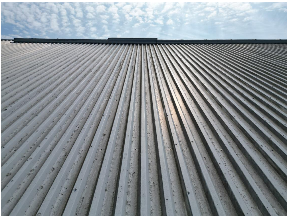
Hallens metal tag (trapezplader) fra 1999 (dronefoto)
