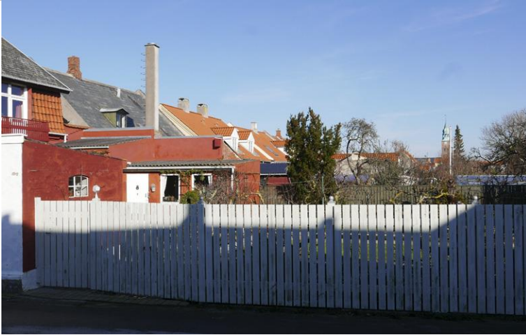
Hegn i skel mod Grevsensgade udført som et plankeværk (enkelt bræddehegn). Over hegnet er der kig til haver og gårde med beplantning og forskellige småbygninger.
