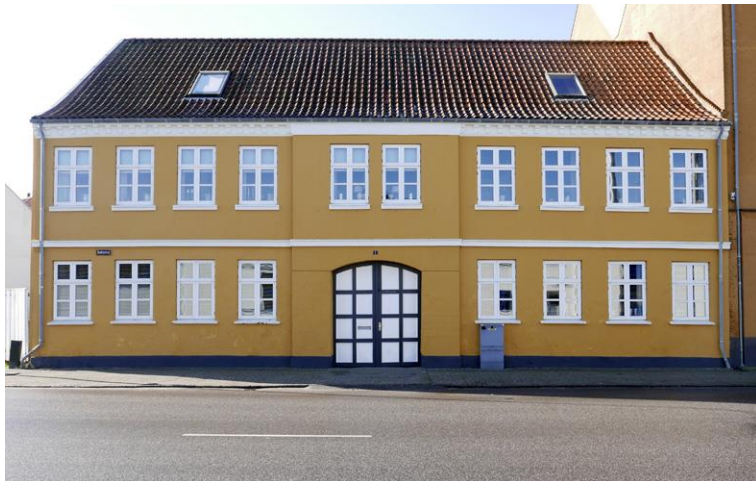
Batterivej 1: Et stort forhus med symmetrisk facadeopdeling og taktfast vinduesplacering. Den store tagflade over gedefacaden er dækket af røde teglsten og brydes af to tagvinduer – et forhold som generelt helst set undgået i fremtiden, selvom de her i placering i nogen grad er tilpasset facadens opdeling.
