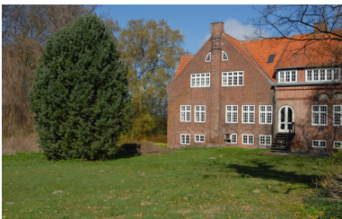
Hovedbygningen på grunden, Antvorskov Højskole, opført 1908.
