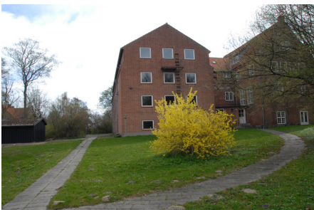
Reg.foto: Tilbygning til hovedbygning set fra vest
