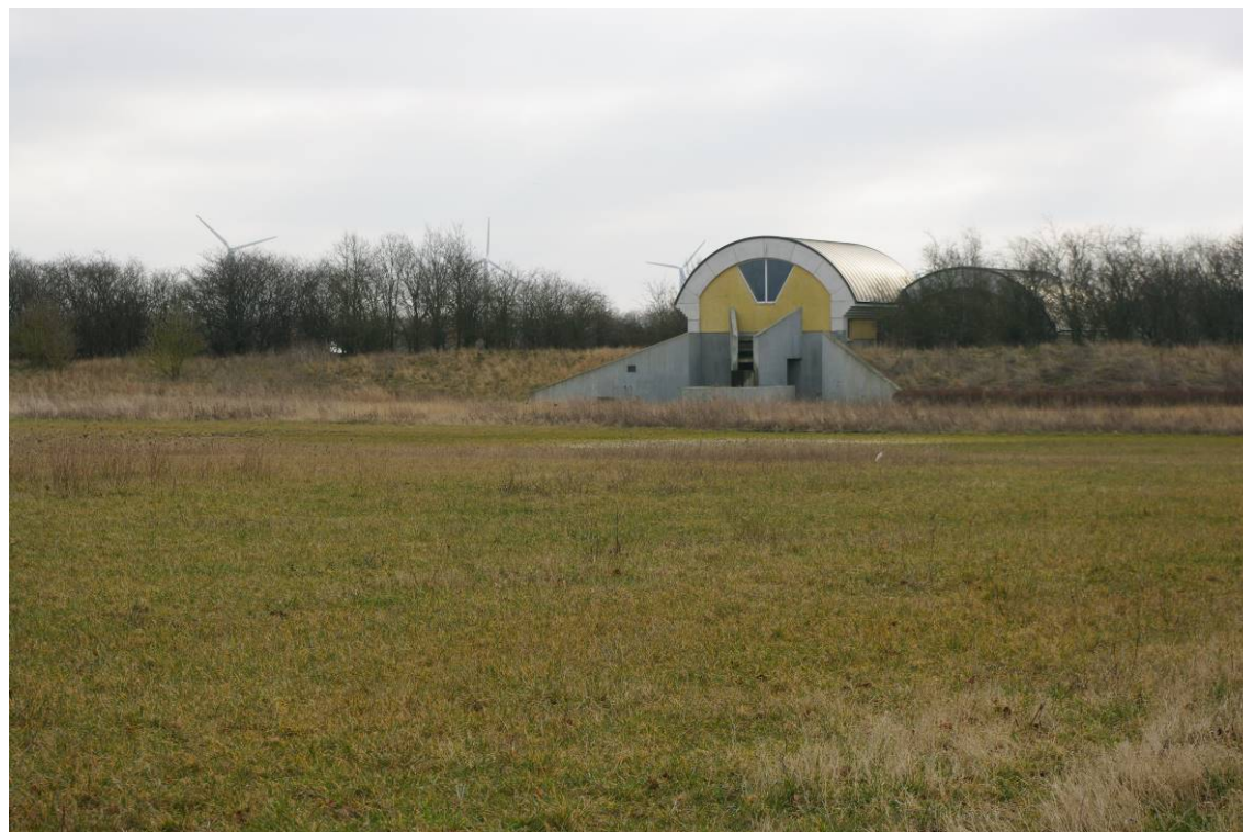
Området ligger i tilknytning til det eksisterende rensningsanlæg ved Slagelse Landevej.
