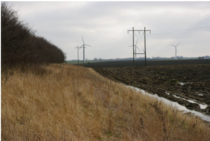
Figur 5 Vindmøller og transmissionsledninger i området. Set fra volden omkring rensningsanlægget.
