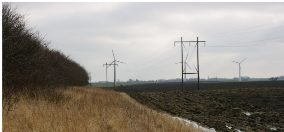
Landskabet er i området præget af tekniske anlæg.
