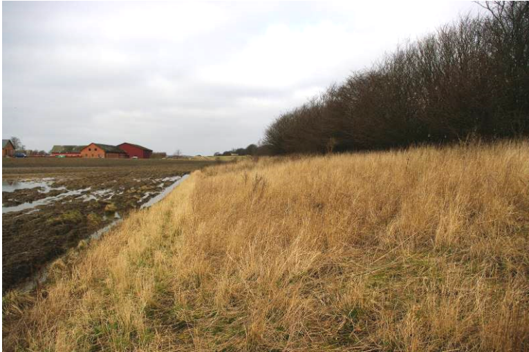
Rensningsanlægget er omgivet af beplantede jordvolde.
