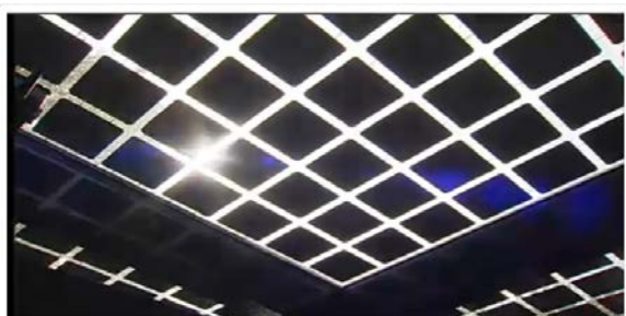
Eksempel på solceller lagt som diskret overdækket terrasse med næsten vandret tagflade. Kilde: Det Grønne Hus i Køge.
