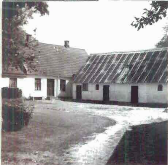
STOREGADE 32, matr.nr. 5a.
