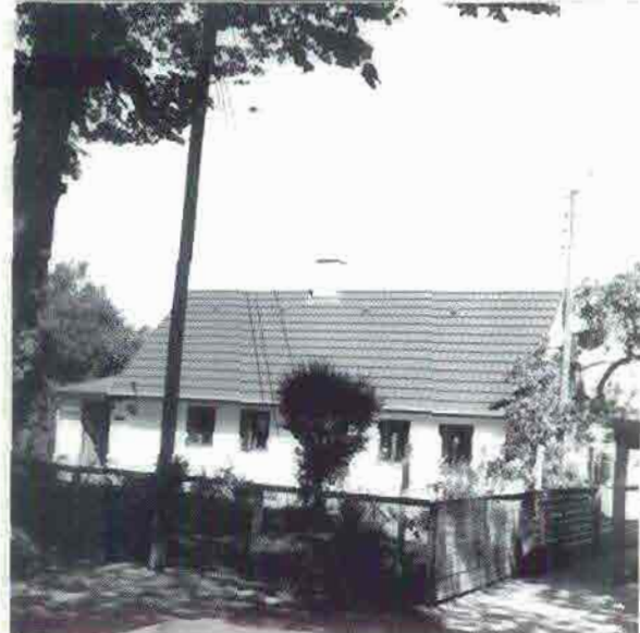
STRANDALLE 14, matr.nr. 9b.
