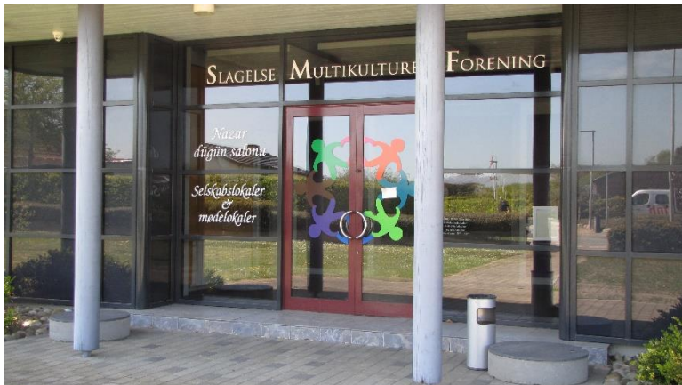
Eksisterende skiltning på facaden ved indgangspartiet.
