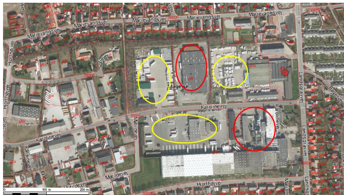
Primære og sekundære støjkloder i forhold til lokalplanområdet (rød prik). Primære støjkloder er vist med røde cirkler og sekundære støjkloder er vist med gule cirkler.
