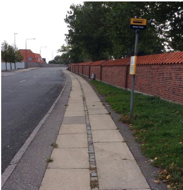
Foto 33: Busstoppested mangler opmærksomhedsfelt og retningsfelt
