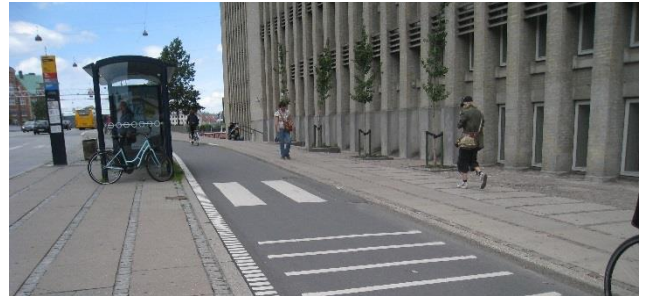
Foto 56: Asfaltrampe på cykelsti ved midterdør til bus.
