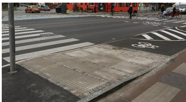
Foto 47: Tilgængelig helle med to-delt løsning med opspring og retningsfelt for synshandicappede og nedsænket kantsten for kørestolsbrugere.
