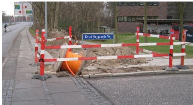
Foto 63: Korrekt opsat afspærring ved vejarbejde.
