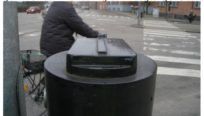
Foto 45: Akustisk signal hvor retningsgiveren peger i den forkerte retning.
