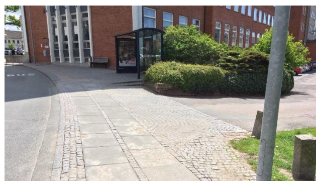
Foto 12: Brostensoverkørsel med gennemført fortov ved Rådhuspladsen i Slagelse.
