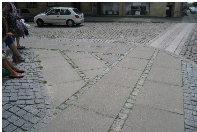
Foto 46: Korrekt anlagt fortov ved hjørne.
