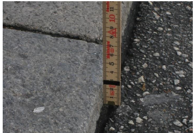
Foto 57: Tømmestok, der måler kantstensopspring.
