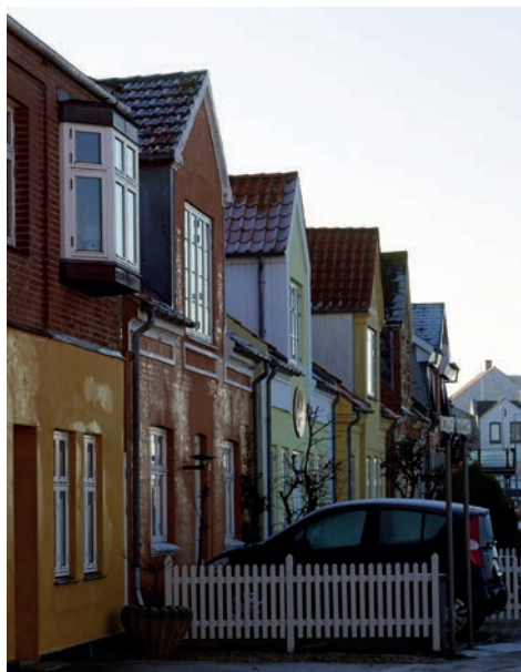
Forhusene i den sydlige ende af Sylowsvej er karakteristiske ved alle at have gavlkviste.
