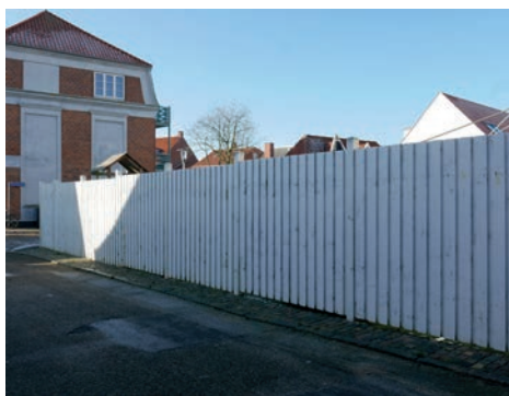
Kirkestræde: Plankeværk udført med beklædning "1 på 2".
