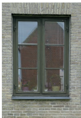
Torammet, seksrudet vindue. Alle ruder er lige store.
