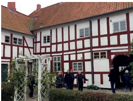
På forhuset Slottensgade 9 er facaden mod gården bevaret i bindingsværk, mens facaden mod gaden blev "moderniseret" og opført i grundmur i 1850'erne. Foto: Hans Jørn Andersen
