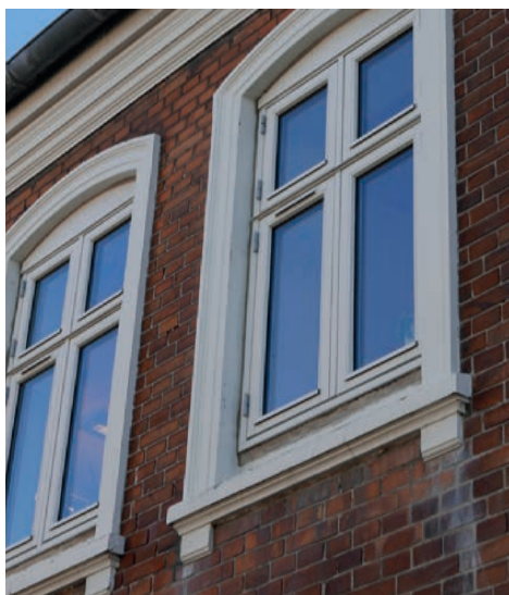
Kraftig og markeret indfatning og sålbænk omkring vinduer er et typisk træk i historicismens facader, hvor man stræbte efter en større reliefvirkning.
