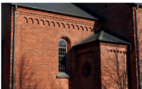
Detalje fra Skt. Povls Kirke. Kirkebygningen blev indviet i 1871, og i facaderne ses flere elementer, som er typiske for historisk byggeri: Blank mur, gesimser med forskellige dekorative profiler, formsten ved vinduesåbninger mm.
