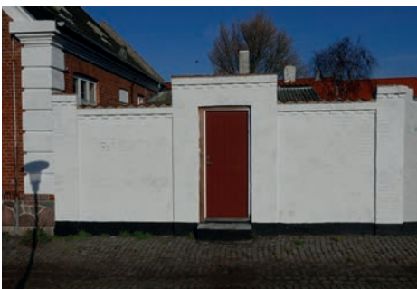
Rosenstræde: Pudset/malet hegnsmur med afdækning af vingeteglsten og med indgang til gård/have. Hegnsmuren opleves som en del af den sluttede randbebyggelse.
