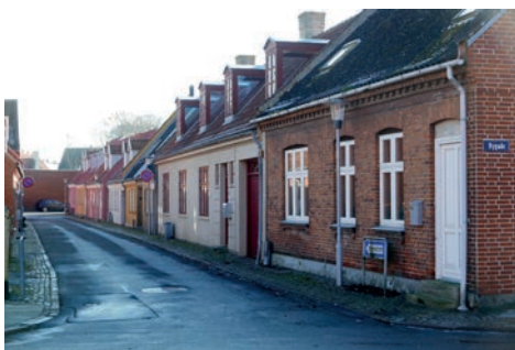
Tæt sammenbyggede, lave byhuse i Baggade med 3-5 fag og sadeltaf.
