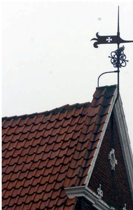
Gavlkam med vingeteglsten og tagflade med falstagsten.
