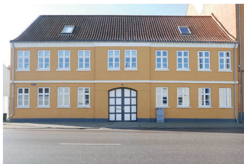
Batterivej 1: Et stort, klassicistisk forhus med symmetrisk facadeopdeling og taktfast vinduesplacering. Den store tagflade over gadefacaden er dækket af røde teglsten. Tagfladen brydes af to tagvinduer – et forhold som generelt ønskes undgået i fremtiden.
