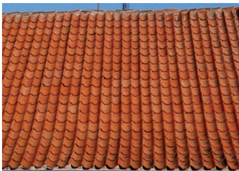
Tag af ubehandlede, røde vingeteglsten.
