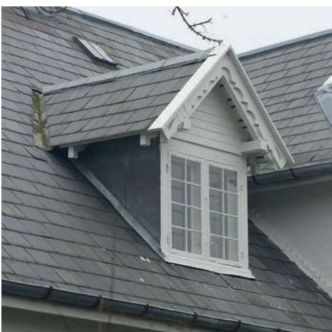
Heltagskvist med tagudhæng og udskårne udhængsspær (schweizerkvist).
