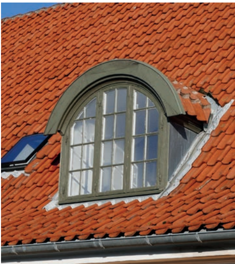
Heltagskvist med tøndehvælvet tag. Til venstre for kvisten ses et moderne, 6-stens tagvindue.
