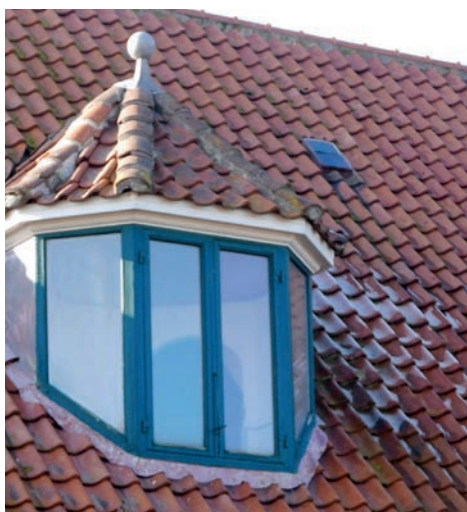
Til højre for den fine, "kantede" kvist ses et traditionelt 4-stens støbejernsvindue.
