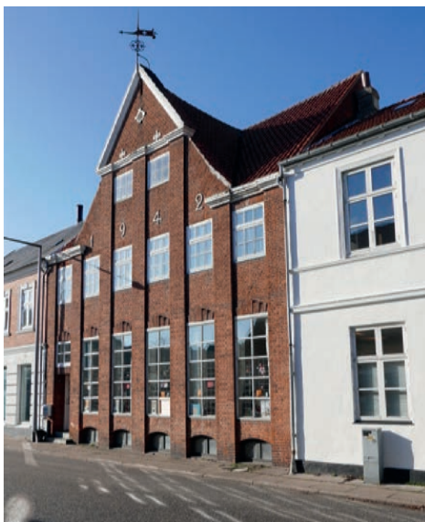
Forhuset Brogade 2 er opført i 1942 i samarbejde med foreningen (eller rettere bevægelsen) Bedre Byggeskik.
