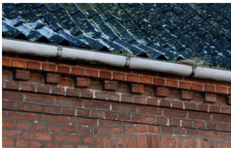
Muret hovedgesims med tandsnitsprofilering.
