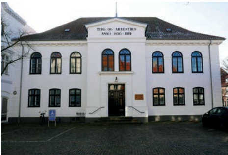
Ting- og arresthuset i Algade ved Torvet er et senklassicistisk hus, opført i 1851 - dog viser de buede overkanter på vinduerne, at nye stilmæssige idealer er på vej.
