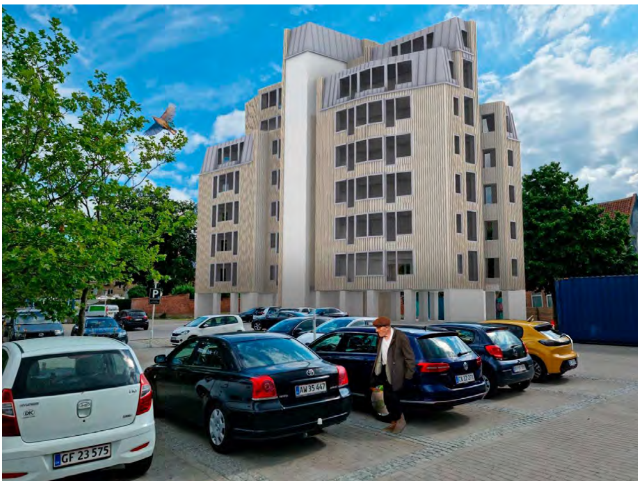
Illustration 1. Perspektiv af punkthuset set fra biografen. Den omdannede plads er ikke illustreret.
