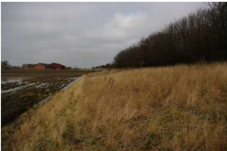
Rensningsanlægget er omgivet af beplantede jordvolde.
