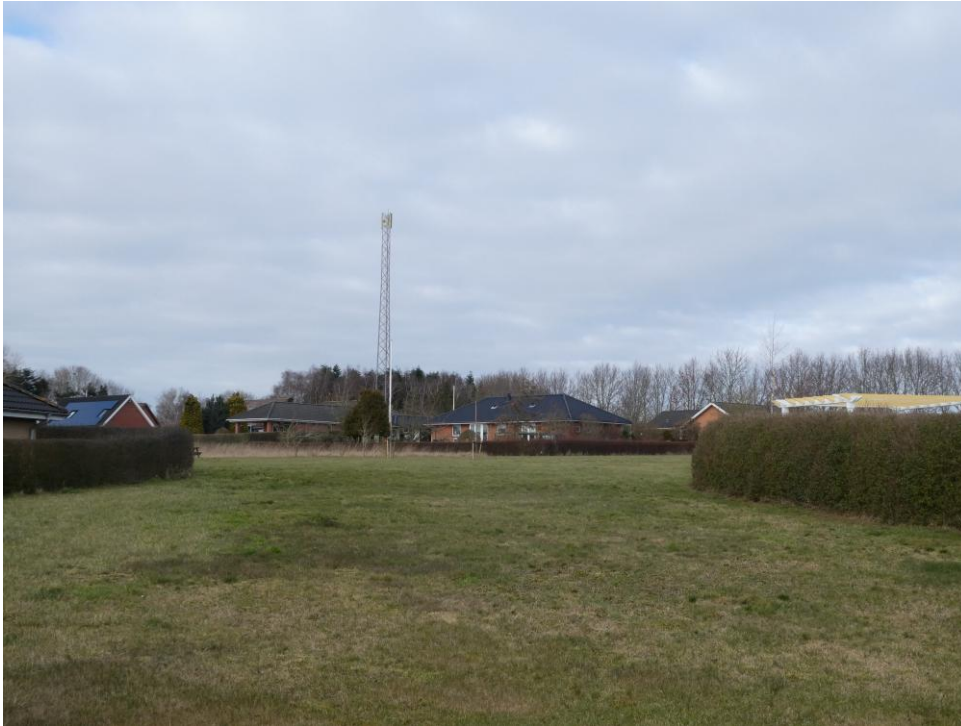
Masten set fra Hylleparken. Afstand: 244 meter.
