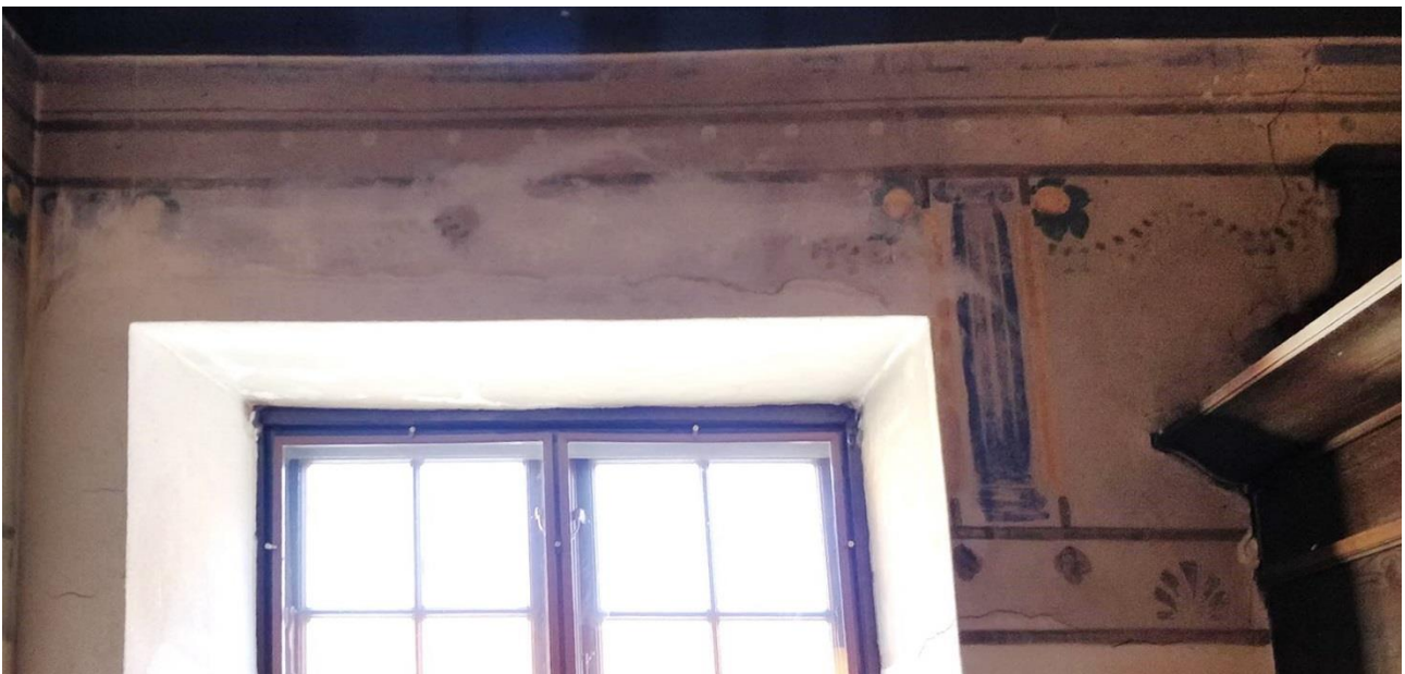
I denne vindues niche er pudsens faldet ned og der er udført en puds reparation. De bemalede dekorationer i nichen er således gået tabt og skal rekonstrueres efter det andet vindue
