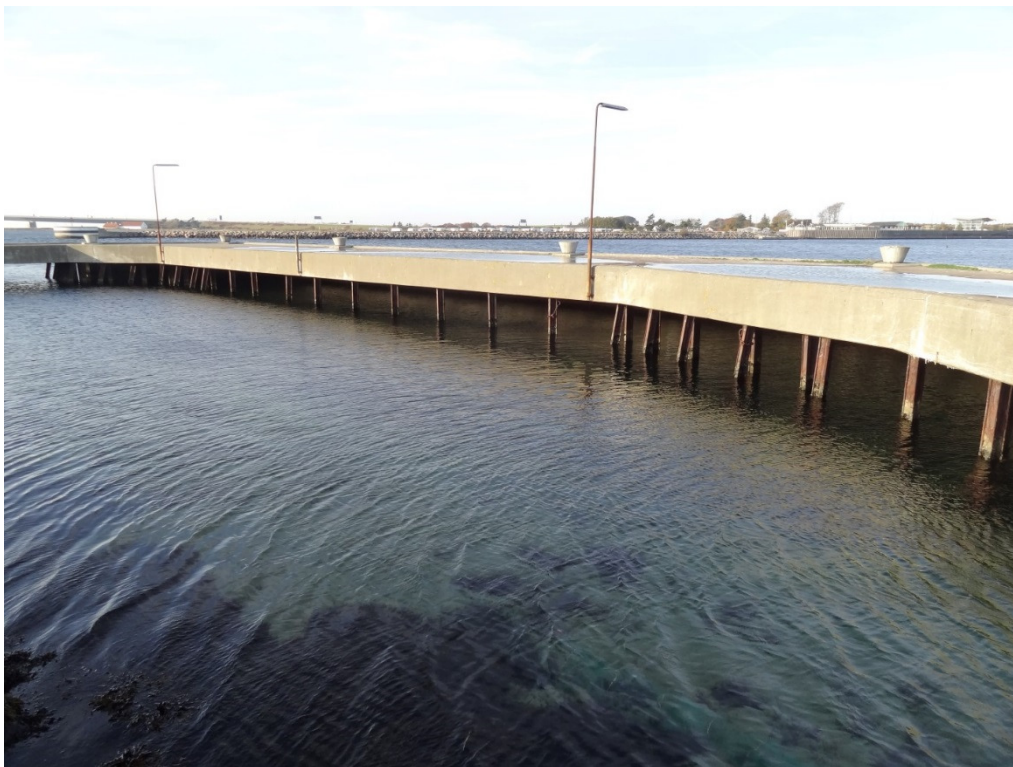
Foto 20: Indersiden af Oliepieren set fra st. 320 mod nordvest.
