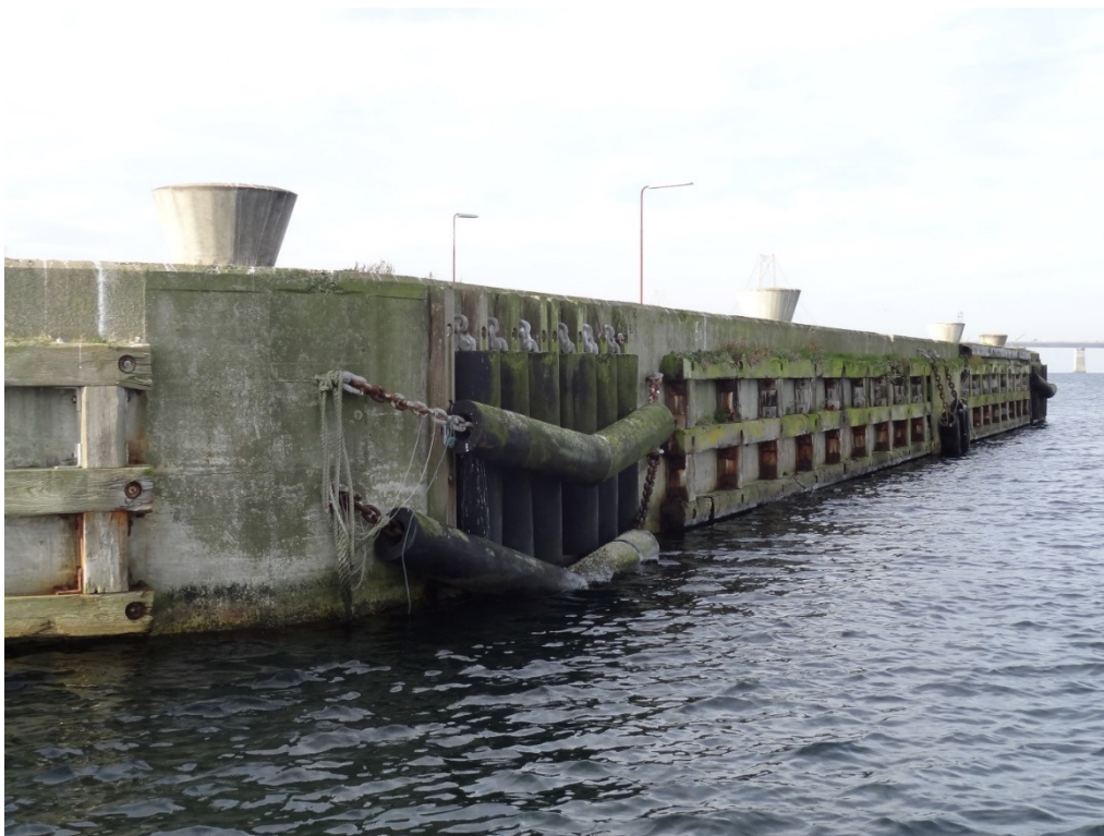
Foto 21: Front af Oliepieren mod nord med friholdertømmer i træ og gummifendere.
