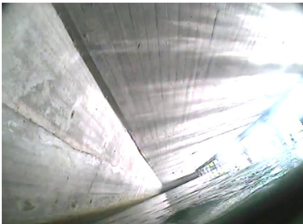
Foto 25: Sund beton på undersiden af Oliepieren.
