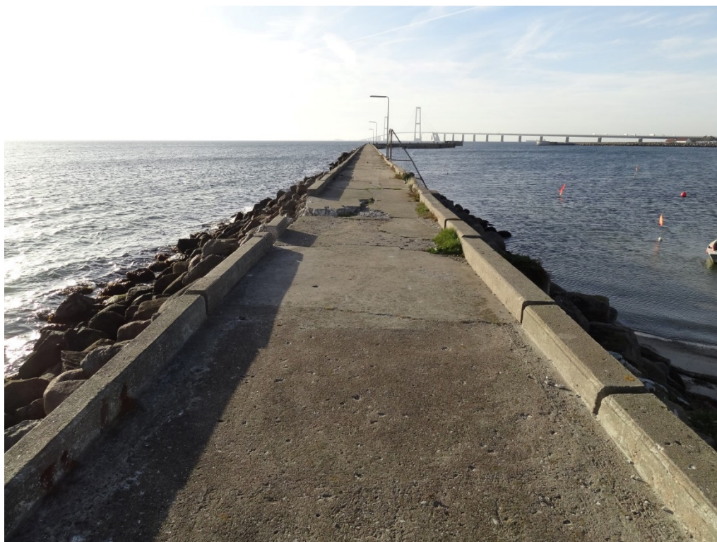
Foto 3: Sydlige mole ved st. 50.
