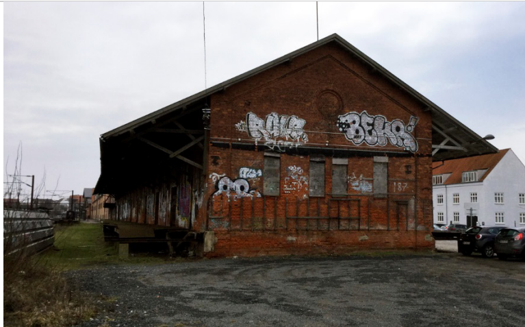
Godsbanebygningens vestgavl som den står i dag.
