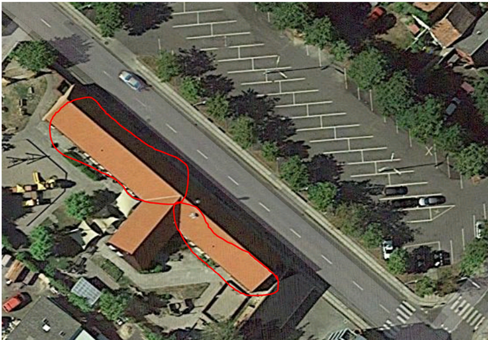
18. Børnehaven Mariehønen, Grevsensgade, Korsør, 6 kwp
