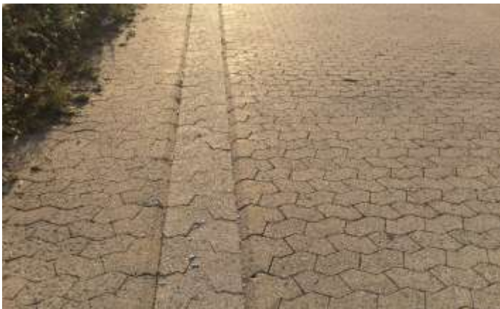
Eksempel på integreret regnvandsrende i kørebane.
