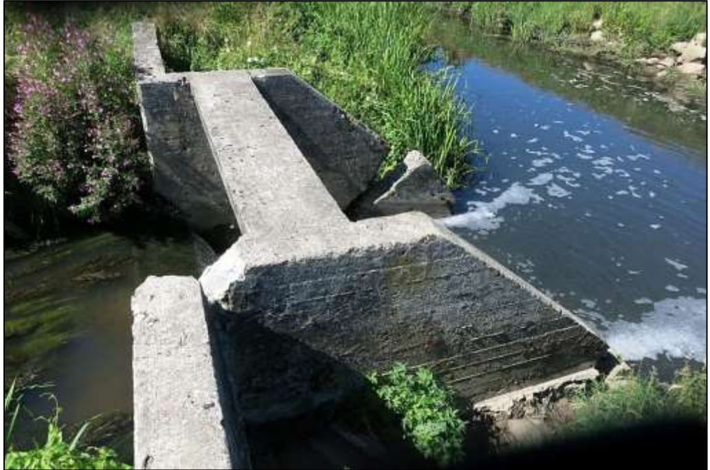
Figur 2-5 Betonbygværket, der udgør spærringen.
