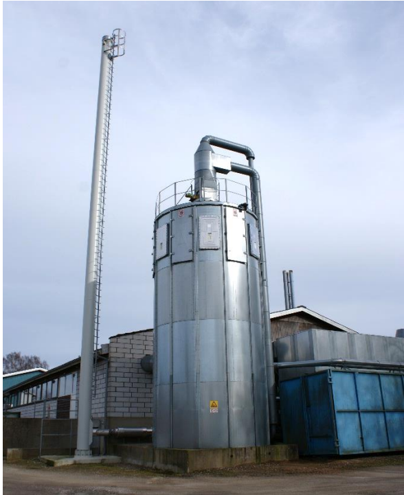
Eksisterende silo og skorstene.
