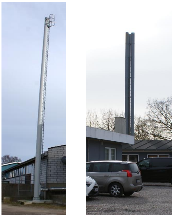
Den eksisterende virksomheds to skorstene.
