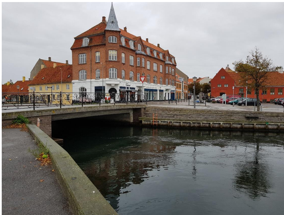
Figur 2-5 Den flotte bro hvor Vestergade krydser kanalforbindelsen mellem havnen og Noret. Broen med smedejernsrækværket med købstadens våben er fra 1906 og er efterfølgende gjort tidssvarende i bredden i 1958.
