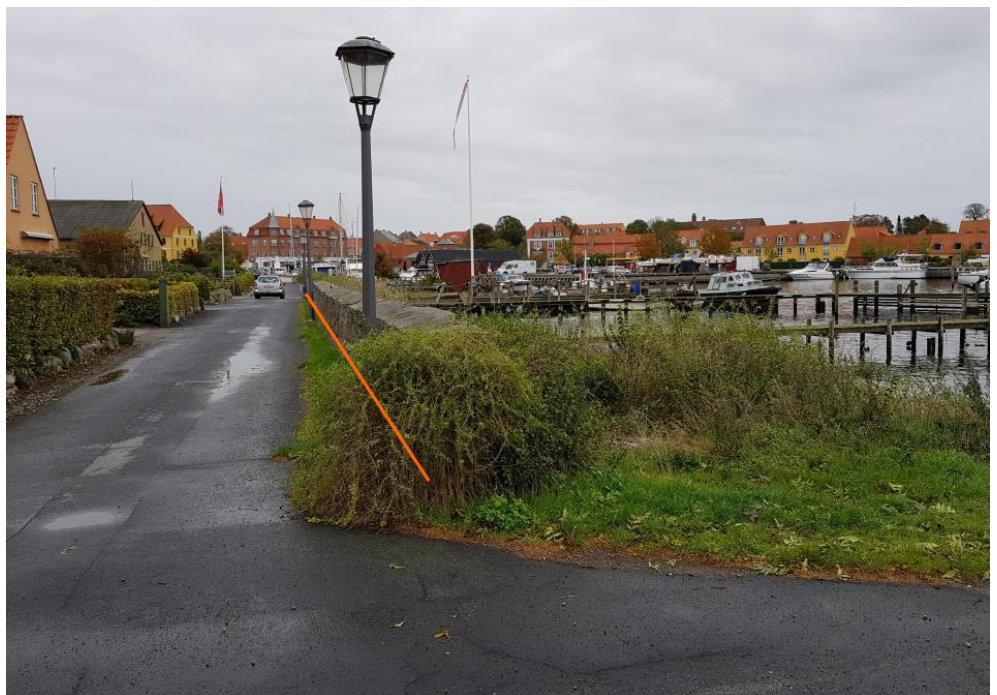
Figur 6-10 Placering af renoveret betonmur langs, strækning E-F
