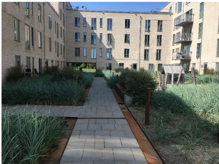
Eksempel på hvordan render til regnvand er integreret i gårdrum.
