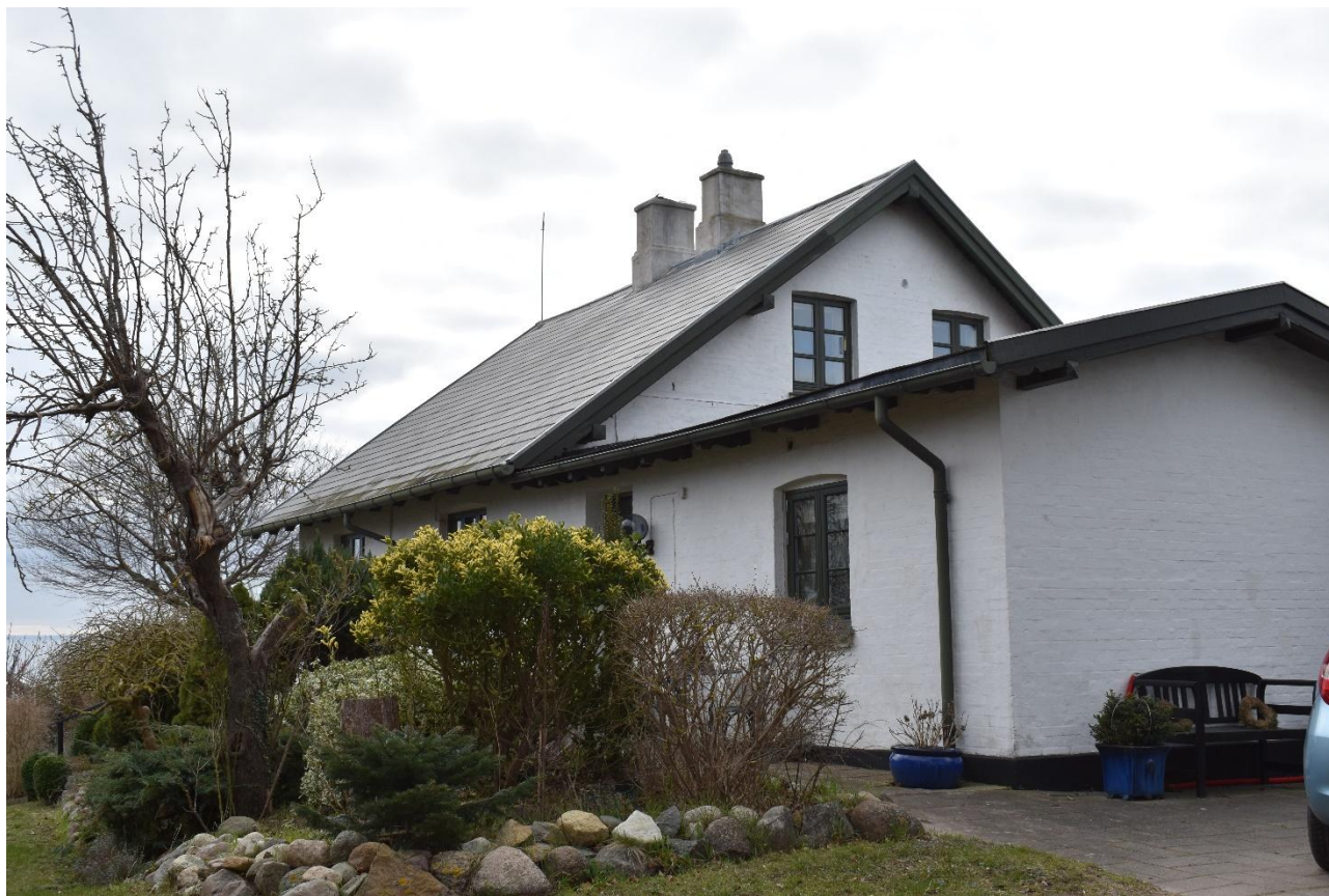
Tilbygning til villa, set fra sydøst
