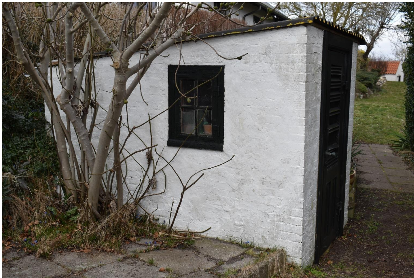
Bygning set fra vest
