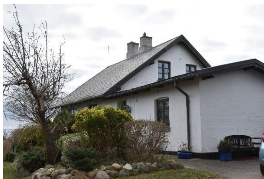
Den tidligere fyrmesterbolig med lanterne i gavlen og tilbygning.
