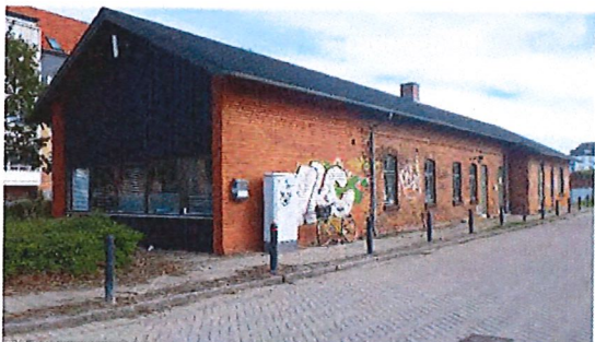
#17 Bygning opført før 1954, Ndr. Stationsvej 3C
