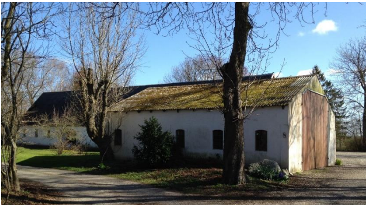
Udhus med lav taghældning (Smedevej 8).
