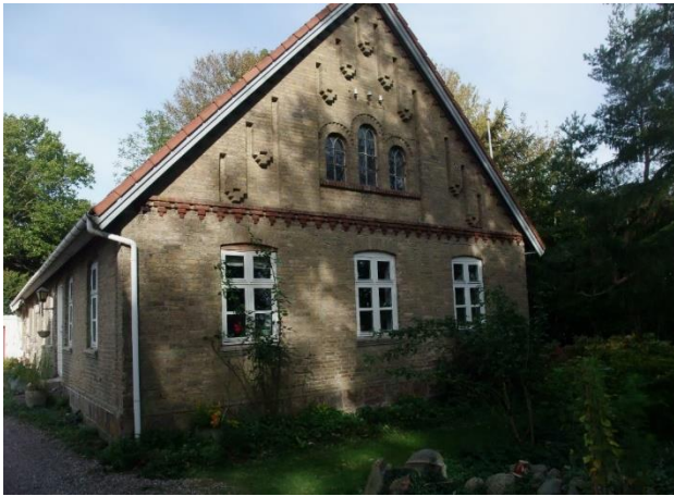
Pilevangsgaards gavl på stuehus
