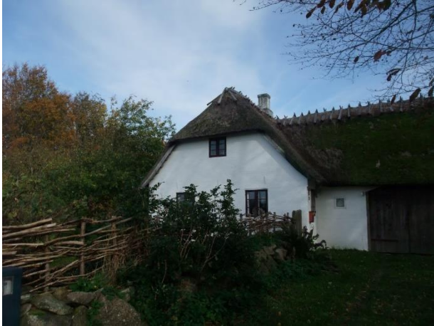
Aagårds beboelse- og tidl. driftsbygning er sammenbygget
