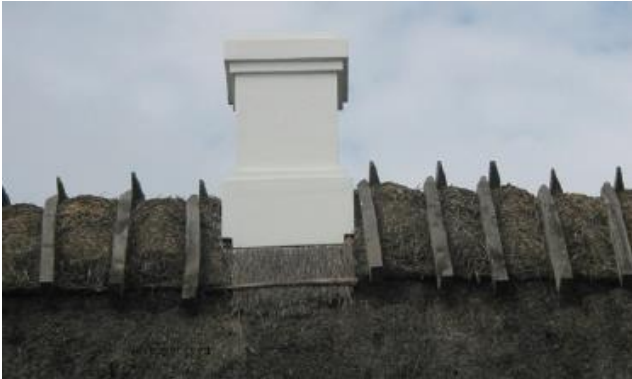
Eksempel på skorsten i en stråtækt ejendom
