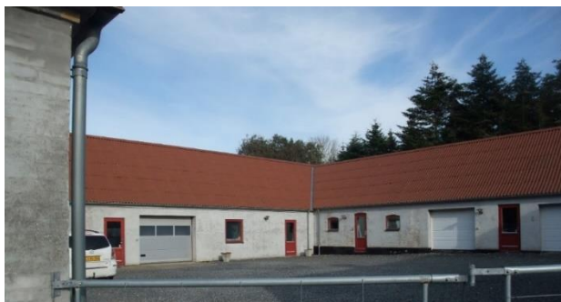
Tværgaards eksisterende nord og øst længe
