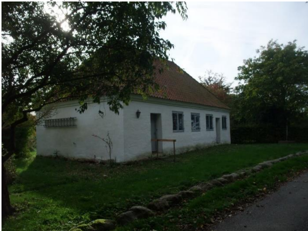
Rytterskolen beliggende Smedevej 2, den ældste bygning i landsbyen
