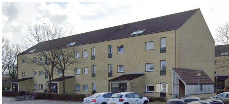
Eksempel på en blok af etageboligerne, Snedkervej 1-5, set fra nord (1981)
