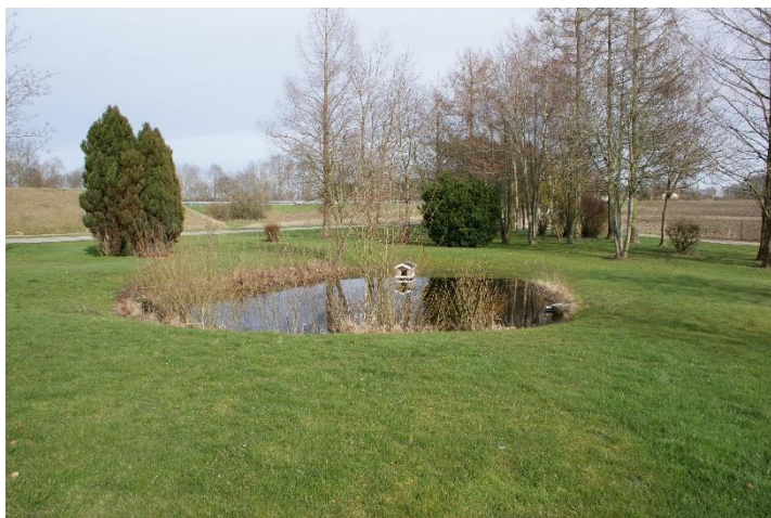
Eksisterende sø der fungerer som regnvandsbassin.
