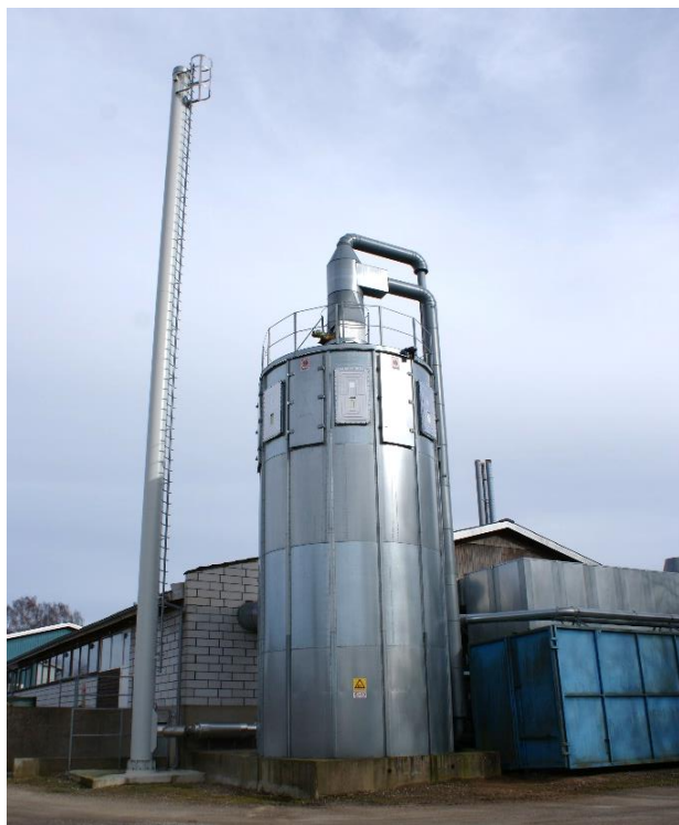
Eksempel på eksisterende tekniske bygningselementer: To skorstene og en silo samt en teknisk bygningskonstruktion på gavlen
