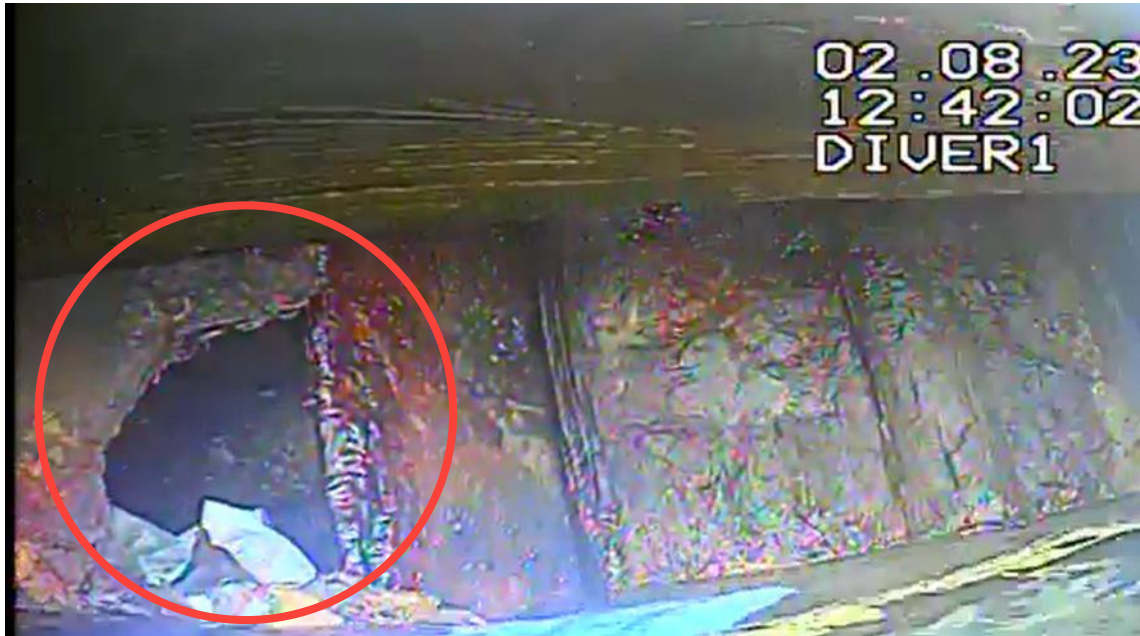
Figur 21: Billede fra dykkervideo. Hul markeret med rød cirkel.
