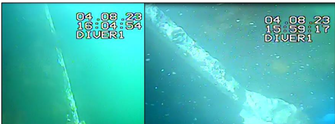
Figur 11: Fotos fra dykkervideo, anode beslag uden meget materiale.
