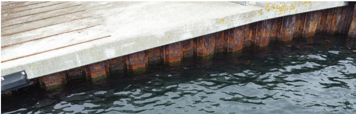
Figur 15: Spunsvæg over vand ved ro-ro leje nord.
