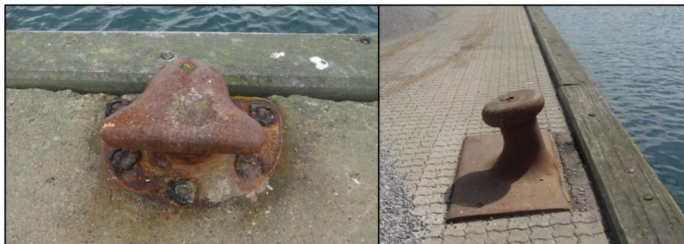
Figur 19: Pullerter fra st. 390 til ca. st. 480, tv. Pullerter fra ca. st. 480 til st. 843, th.
