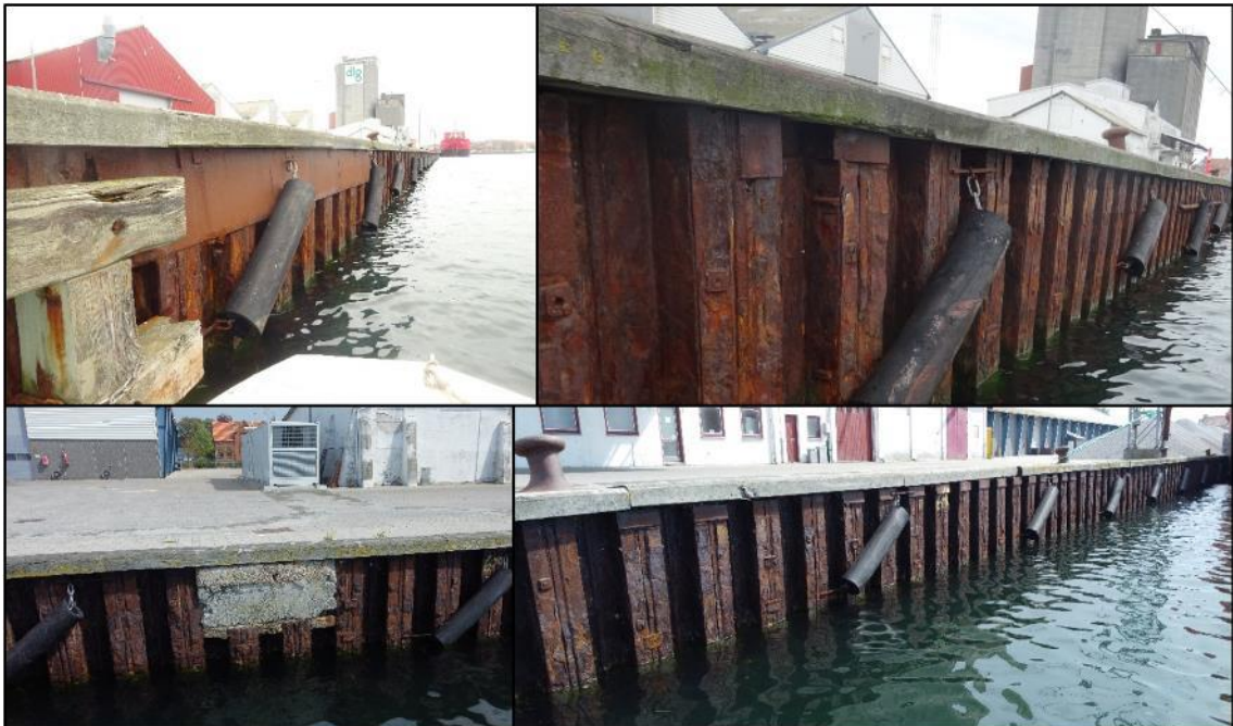
Figur 18: Fra øverst til venstre mod nederst til højre, stålplade ved overgang mellem stålprofiler, to stålplader fastgjort i top af væg, betonstøbning i ca. en meters højde, og stålplader fastgjort i top af væg.
