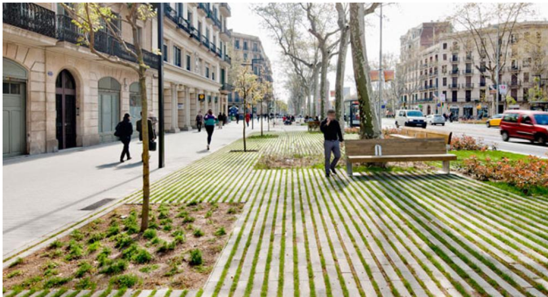
Eksempel på grønne fuger i belægning
