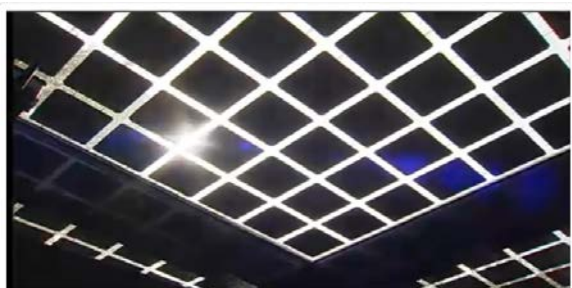
Eksempel på solceller lagt som diskret overdækket terrasse med næsten vandret tagflade. Kilde: Det Grønne Hus i Køge.
