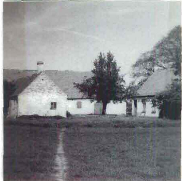
STOREGADE 6, matr.nr. 9a.
