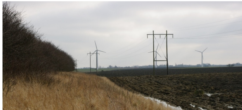
Landskabet er i området præget af tekniske anlæg.
