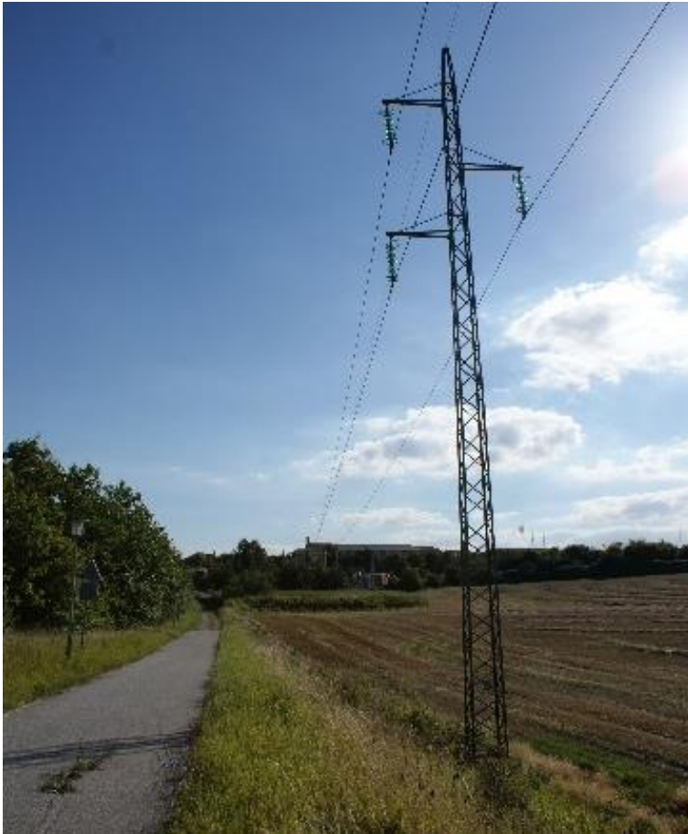
Eksisterende 50 KV luftledning som udgår fra transformerstationen i baggrunden af billedet.
