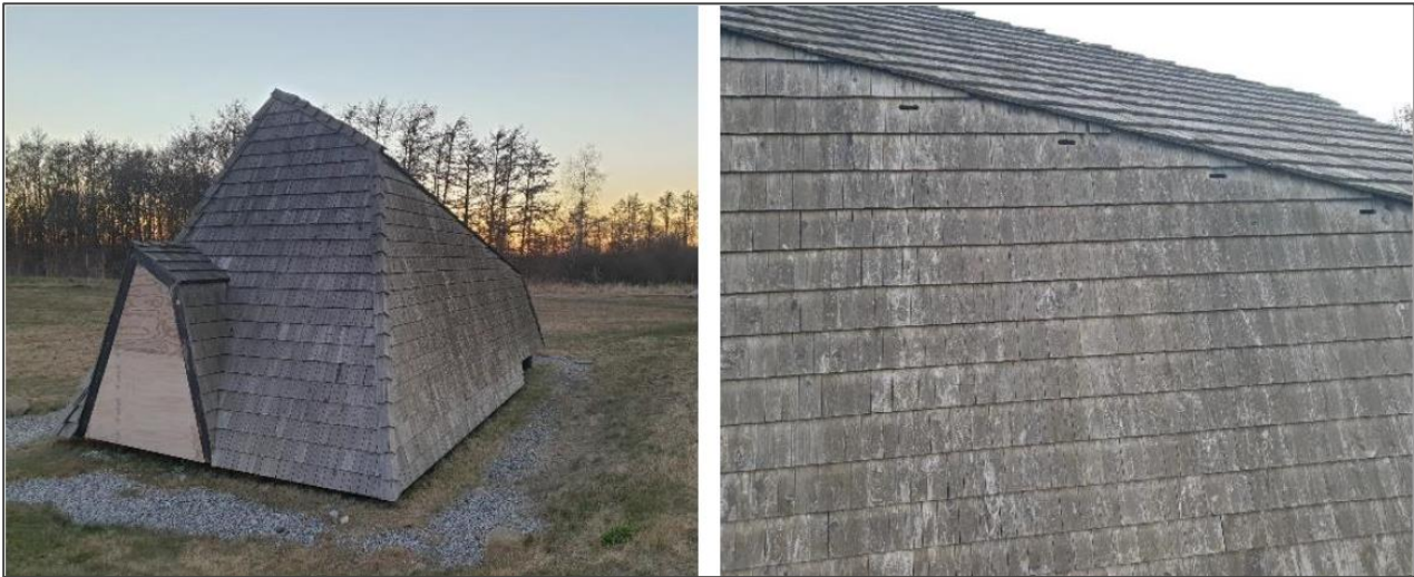
Figur 5.10: Flagermushotel i Solrødgård Klima – og Miljøpark. Foto: Niras, 2022.
