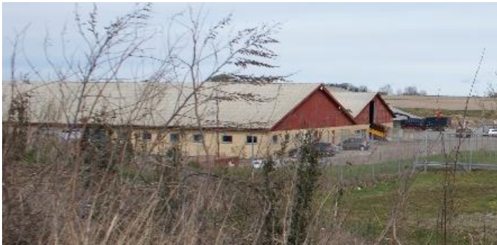
Eksempel på eksisterende byggeri på Miljøcenter Enggården (Slagelse Miljøcenter). Bebyggelsen fremstår med murede facader.
