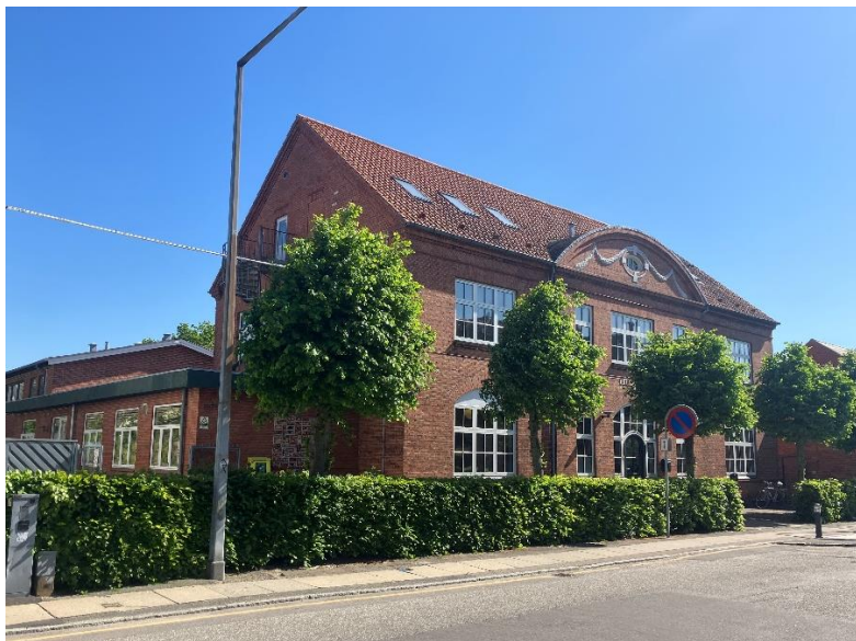
Hovedbygning på Dahlsvej 8.
