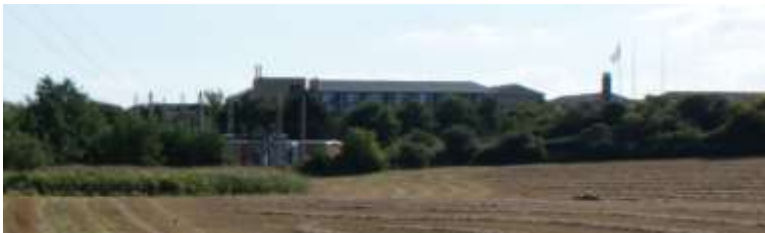
Transformerstation i baggrunden og et potentielt beskyttet naturområde i forgrunden. Området omkring det potentielle naturområde ligger lavt (under kote1,5).
