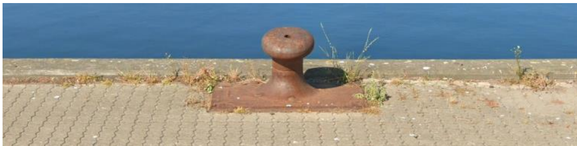
Figur 6: Eksempel på kajkant af beton på Amerikakaj.
