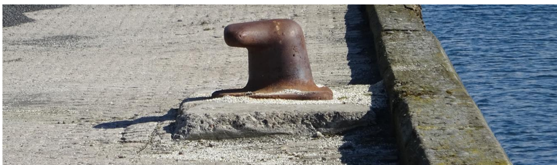
Figur 7: Eksisterende pullert på Kaj 301-303.
