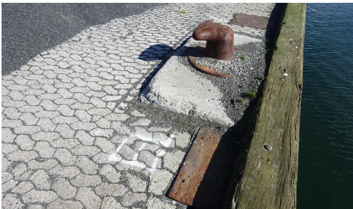
Figur 9: Eksempel på eksist. brønde til e- og vandforsyning.
