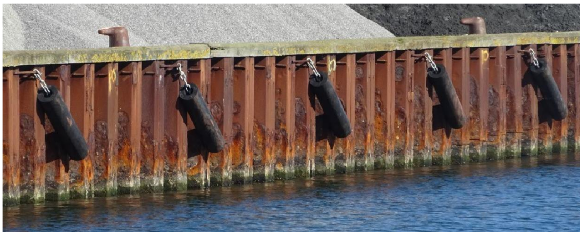
Figur 8: Eksisterende fendere på Kaj 301-303.
