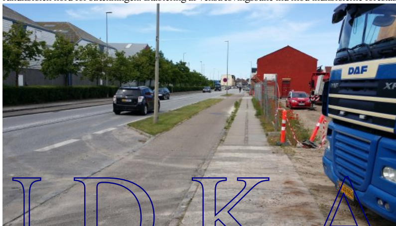
Strækningen nord for Elværksvej.
