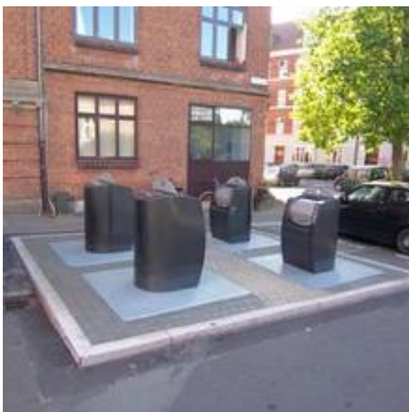
Billede 2: Fælles nedgravede beholdere i Århus. Beholderne er fuldt nedgravede.
