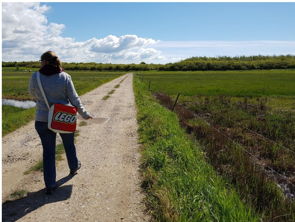
Figur 3-4 Besigtigelse af området ved Saltengen. Vejen ligger meget lavt og skal forhøjes. Derudover skal der højvandsklap i underføring under vejen, så den fungerer som en del af det samlede højvandsværn.
