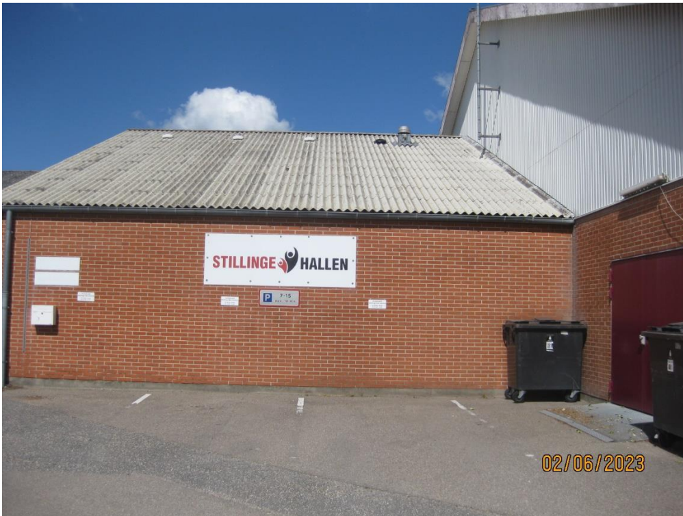
Bølgeeternittag fra 1988 med asbest
