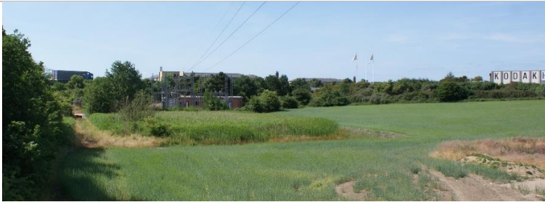
Transformerstation i baggrunden og et potentielt beskyttet naturområde i forgrunden. Området omkring det potentielle naturområde ligger lavt (under kote 1,5).
