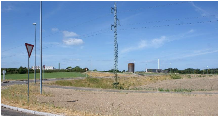
Eksisterende 50 KV luftledning som udgår fra transformerstationen i den sydlige del af delområde 1 op mod Vestmotorvejen.
