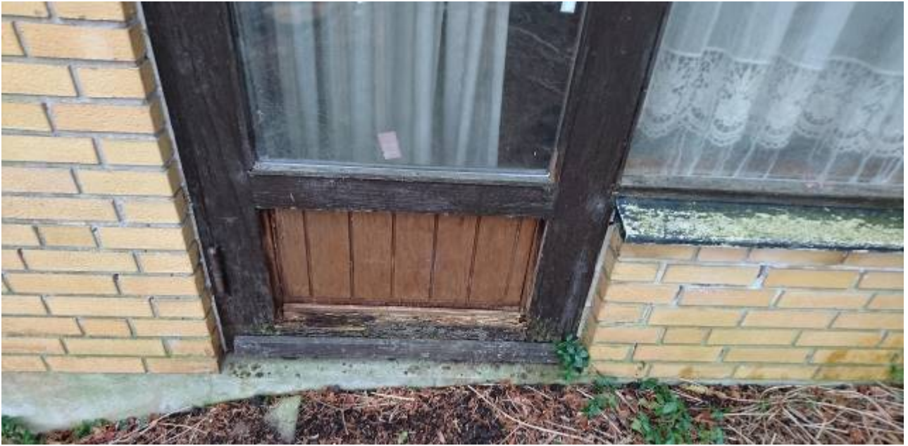
Terrassedør hvor fyldningen reelt mangler, finerpladen er ikke helt fastgjort.
