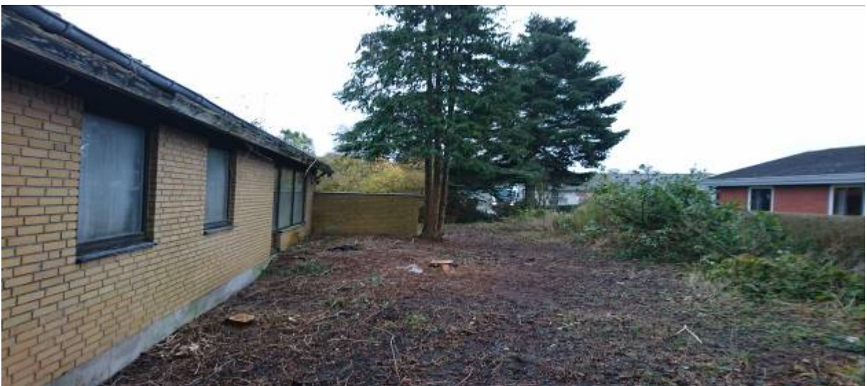
Huset facade mod havesiden.
