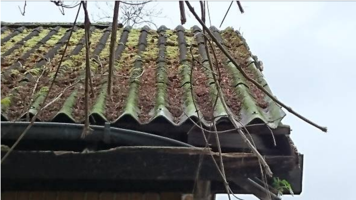
Manglende rygning og dækbræt mod akacievej. Dette er ens for begge gavle.
