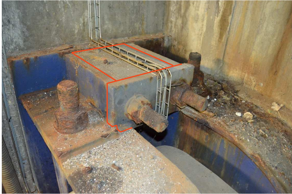
Figur 5 Forankring af cylinderfæste med forspændte bolte.
