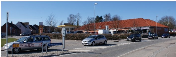
Forbindelsesvejen mellem Kalundborgvej og Valbygårdsvej.
