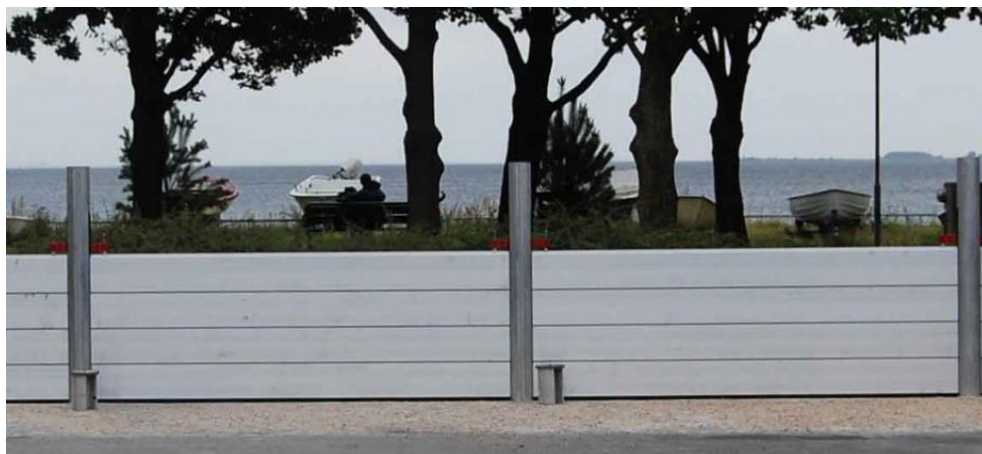
Figur 9-4 Eksempel på system 1 med bjælkeelementer. Her dog opdelt, hvilket ikke er en nødvendighed for passagen.
