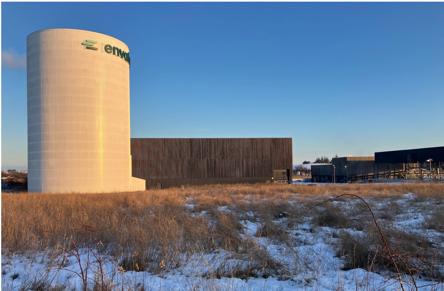
Halsskov - her varmeakkumuleringskøle og hal med produktionsanlæg til fjernvarme. Foto: Slagelse Kommune
