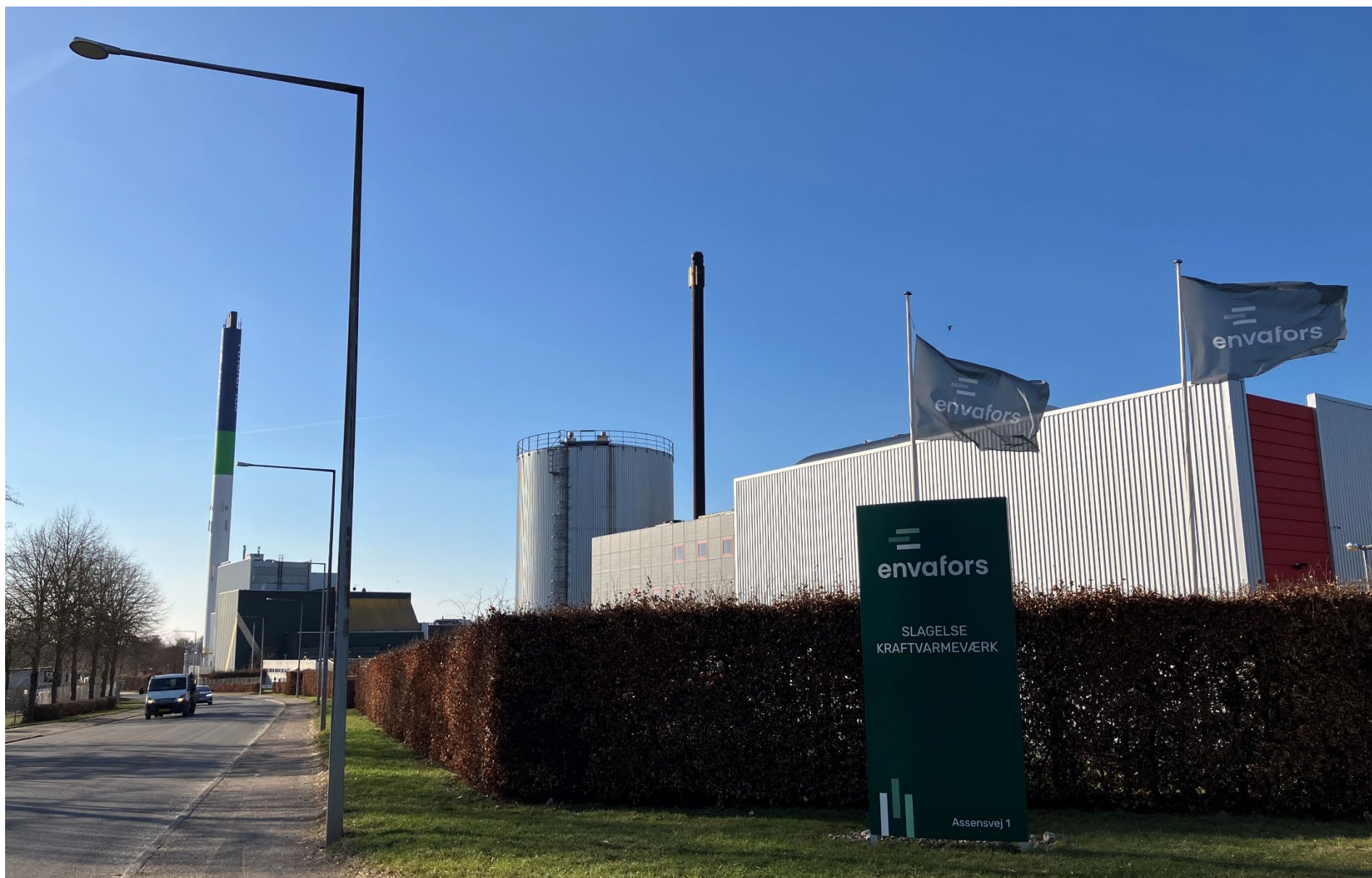
SK Varmes produktionsanlæg på Assensvej i Slagelse. Foto: Slagelse Kommune
