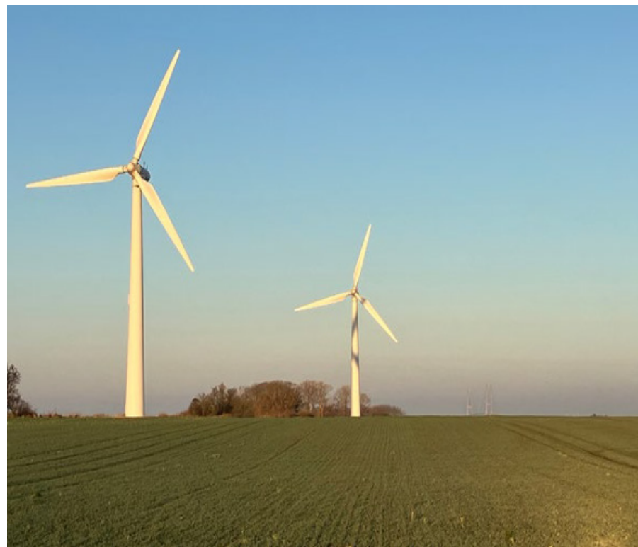
Det er målet, at Slagelse Kommune skal være selvforsynende med grøn strøm senest i 2030. Her vindmøller ved Tjæreby. Foto: Slagelse Kommune
