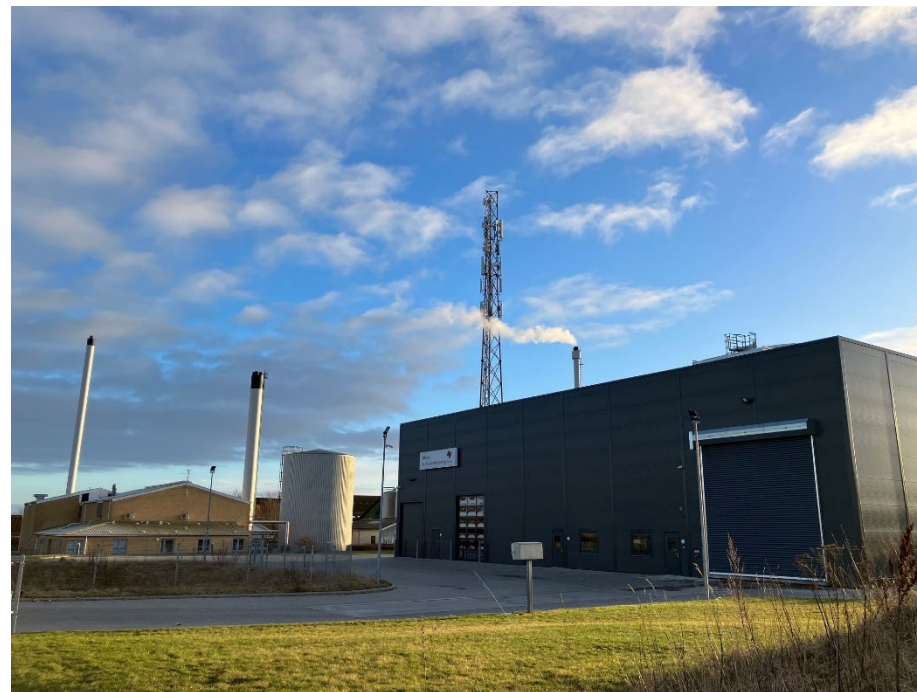
Hashøj Kraftvarmeforsyning a.m.b.a. er kommunens andet fjernvarmeselskab og forsyner byerne Dalmose og Flakkebjerg. Foto: Slagelse Kommune.
