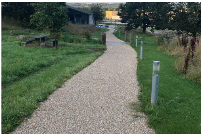
Sti i OB-belægning i en gul/varm farve.
