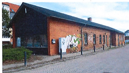
#17 Bygning opført før 1954, Ndr. Stationsvej 3C
