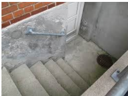
Figur 1: Kælderskakt med afløb for regnvand
