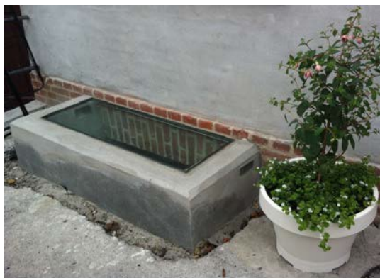
Figur 2: Lyskasse med skybrudssikring og glas
