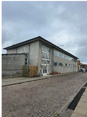
Gavlfacade med murværk.
