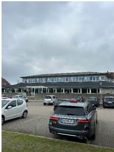
Facadeudsnit af bygning med 1. sal. Tagbelægning er bølgeplader.
