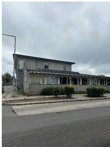
Facadegavl mod Gl. Banegårdsplads med murværk, enkelte vinduer, og dør til brandtrappe.
