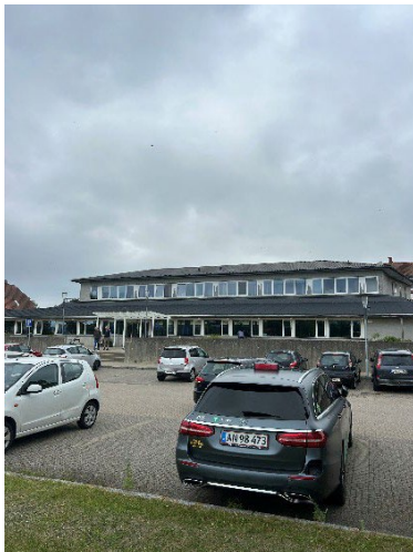
Den høje bygning er med bølgeplader på taget, som med stor sandsynlighed indeholder asbest.
