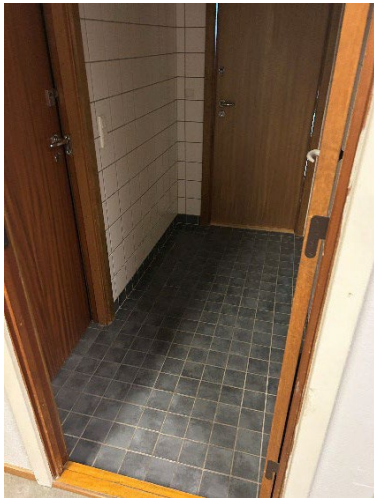
Ved toiletterne er der gulvklinker mod vægfliser. Vægge er tunge vægge.
