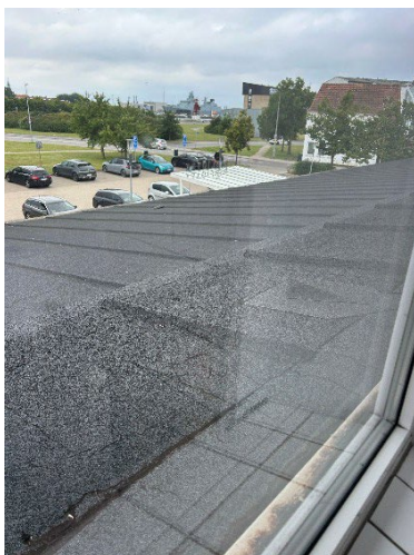
Udsnit af papdækning med trekantslister.
