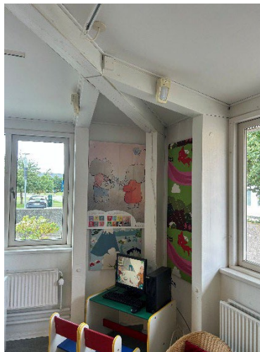
Udsnit af limtræskonstruktion i bygningshjørne.
